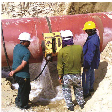
Taglio orizzontale e verticale con E.H. WACHS Trav-L-Cutter Foto: E.H. WACHS
